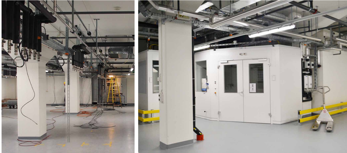
Umbau während Vollbetrieb: Eine der beiden GMP-Musterzugskabinen musste ebenfalls permanent im Einsatz bleiben.
