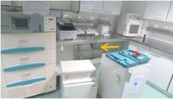
Bild 1: Die Wandverkleidung musste abgenommen werden, um die dahinter liegende Leckstelle (ungeeignete Elektrokabeldurchführung, siehe Pfeil) zu finden.
