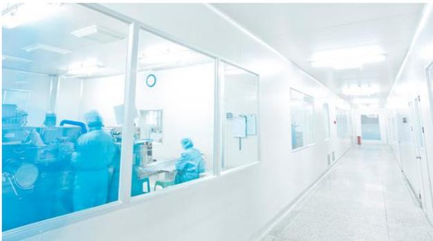
Erst durch die hohe Regelgenauigkeit der SAUTER Systeme wird es möglich, Konzepte mit Druckstufen von 6 Pa gegenüber angrenzenden Bereichen, ohne Gefahr von Cross-Kontamination zu realisieren. Als Nebeneffekt können somit ganze Anlagen kleiner ausgeführt werden, da keine Leckvolumenströme kalkuliert werden müssen. Dies senkt erheblich die Investitions- und Betriebskosten.
